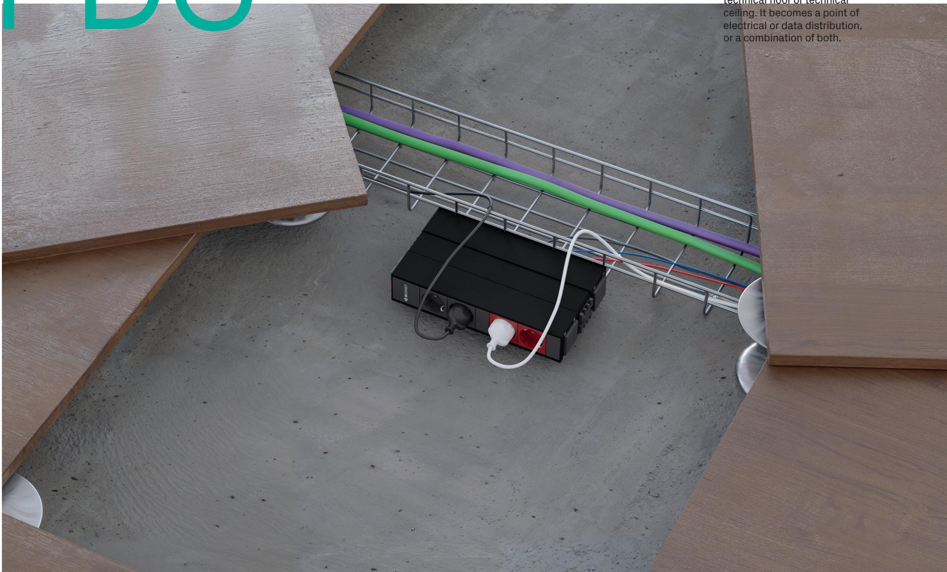
FR. PDC installé sur le plancher technique comme point de distribution de courant et de données.
